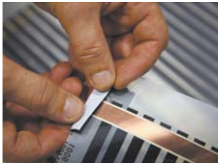
Рис. 6 Изоляция соединений
